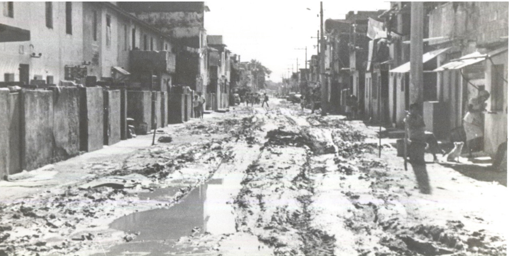
Ruas da Maré sem nenhuma estrutura de saneamento | Foto: acervo Redes da Maré
